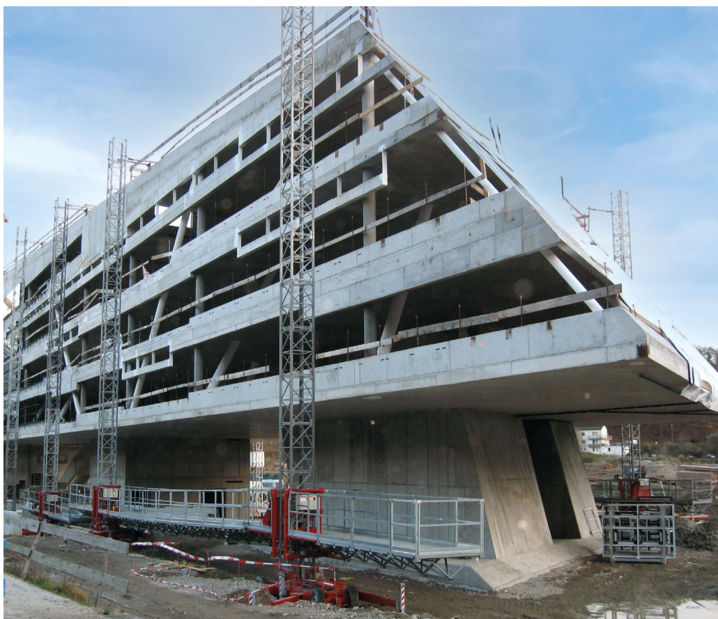
Bauarbeiten JKU Science Park, 2008 (AJKU)
