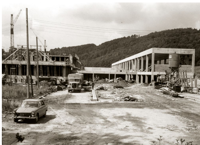
Bauarbeiten JKU Campus, Oktober 1965 (AJKU)
