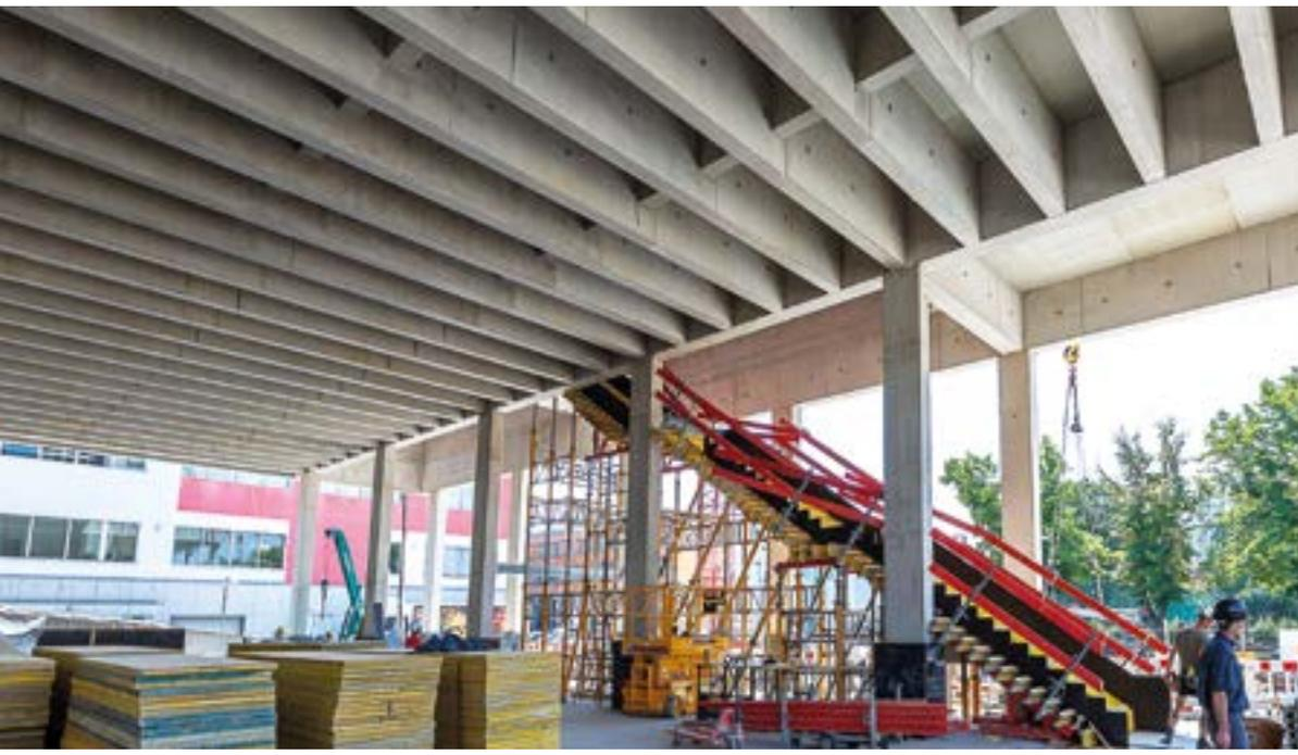
Die in der Errichtung besonders herausfordernde Kassettendecke in Ortbeton im Lehrgebäude über den zwei Hörsälen und dem großzügigen vorgelagerten Foyer wurden von der Strabag AG in besonders hoher Sichtbetonqualität errichtet.
