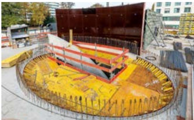
Im Verwaltungsgebäude wurde in exakter Feinarbeit die spiralförmige Treppenanlage in Ortbeton errichtet.
