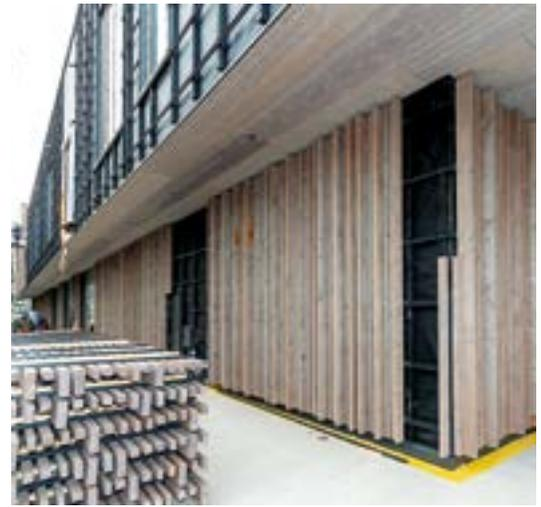
Von der Firma Graf-Holztechnik GmbH kam der konstruktiven Holzbau sowie die Lamellenfassade aus Lärchenholz
