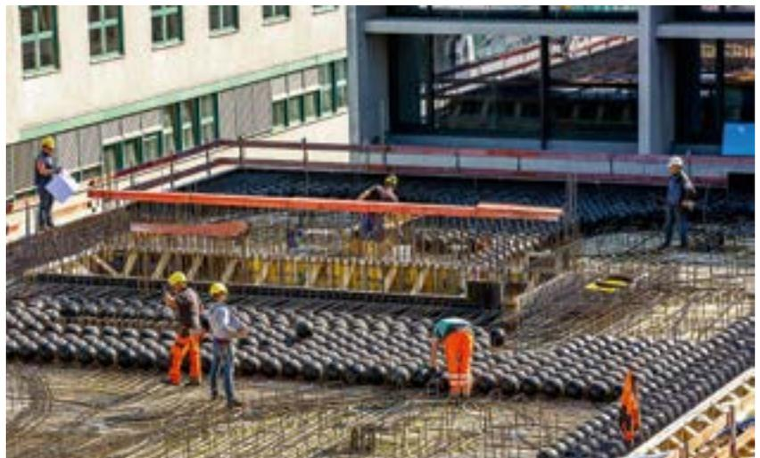
Verlegearbeiten der Hohlkörperdecke mit darunter liegender Betonkernaktivierung
