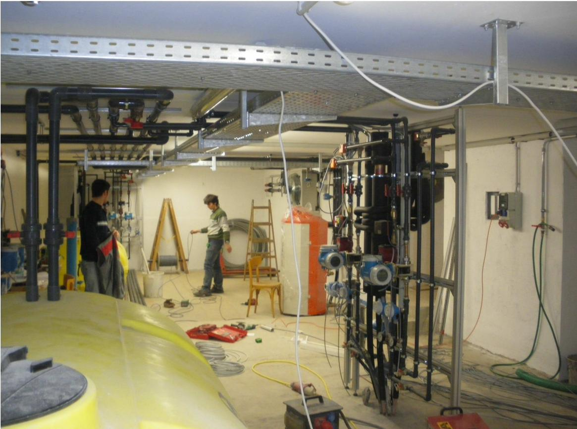
Abb.: 18, Montage und Installation der Sondenperipherie
