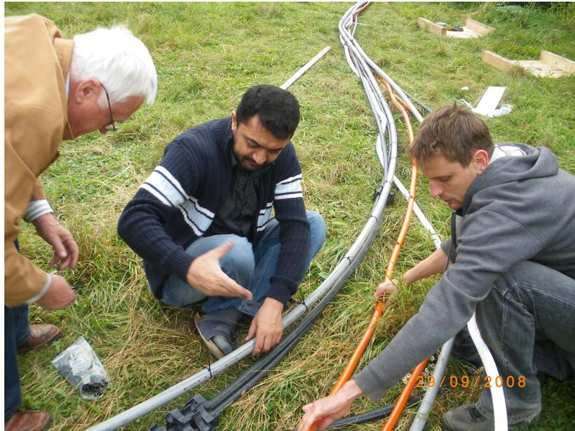
Abb. 16, Ausrichtung der Rohrbündel mittels Abstandshalter
