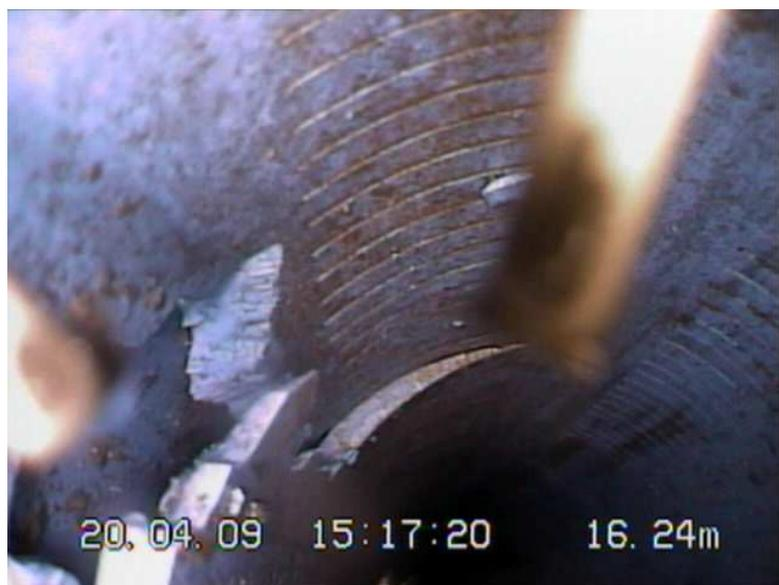
Abb.9, Beschädigung der Mantelfläche des Filterrohres in der Sonde Gamma
